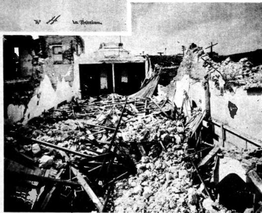
Ruinas de la casa social del Liceo de Regla cuando fué casi totalmente destruída por el huracán del 20 de octubre de 1928. Hoy solo han podido reconstruírse las paredes laterales y el frente del edificio.
